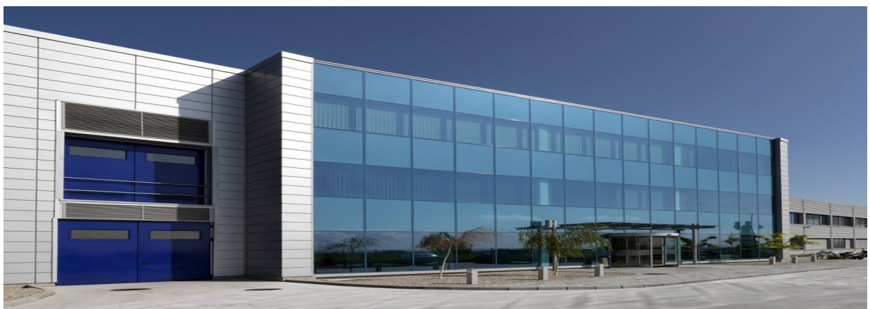
Рис. 5. Приклад використання самоочисного скла Pilkington Aktiv
