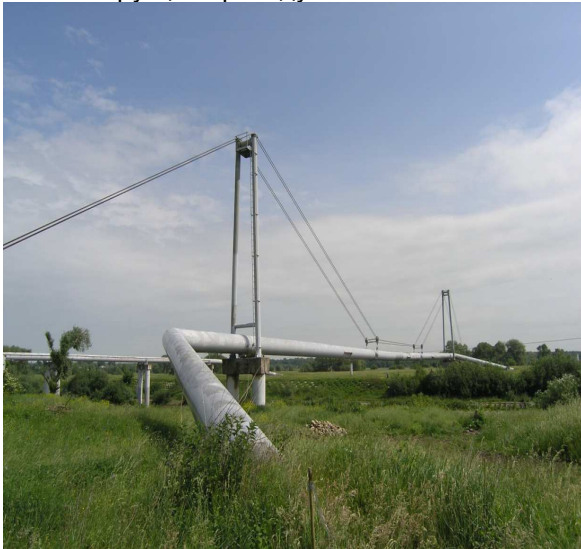
Рис.1 Зовнішній вигляд повітряного переходу.
