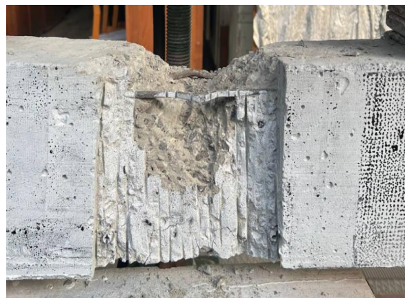
Fig. 9. View of the reinforced concrete beam after the experiment from the damaged side. Рис.9. Вигляд залізобетонної балки після експерименту із сторони пошкодження
