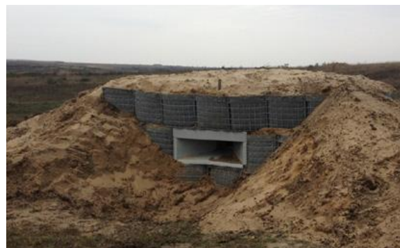
Рис. 27. Захисна споруда з габіонів. [30]
