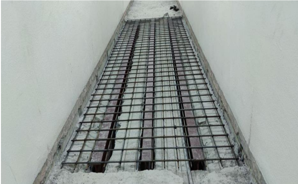
Рис.7. Влаштування елементів підсилення плити металевими балками та армованої фібробетоновою плитою по верх них.
