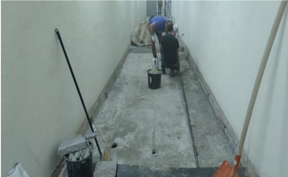
Рис.5. Демонтаж конструкції існуючої підлоги влаштованої по плитам.
