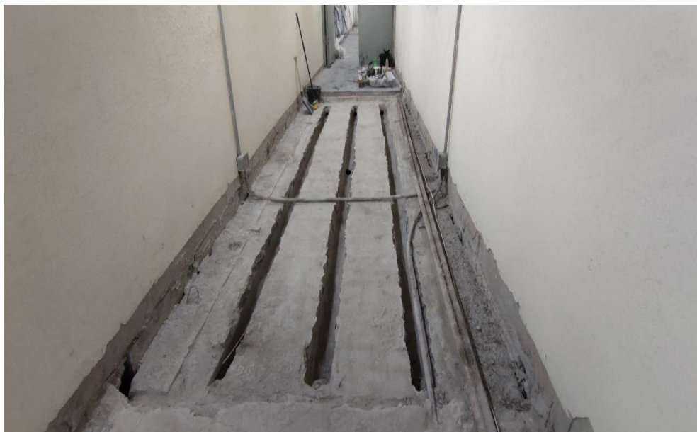
Рис.6. Розкриття порожнин плити відповідно до запропонованої схеми.
