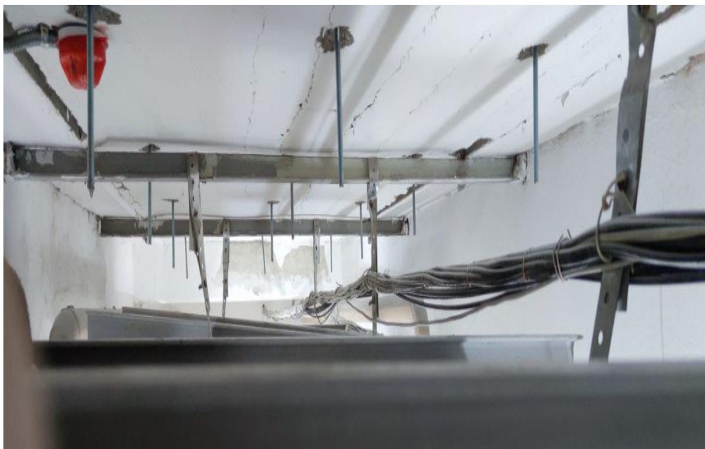
Рис.8. Влаштування елементів підтримки нижньої полицки існуючої плити.
