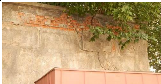
Рис. 6. Тріщина у підпірній стінці w_k=10...30 мм, руйнування оздобленого шару штукатурки і морозна деструкція цегляної кладки
