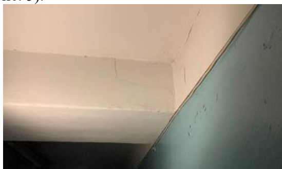
Рис. 5. Тріщина на опорній частині залізобетонного ригеля перекриття по осі «б» в осях «Г–Д», третього поверху
