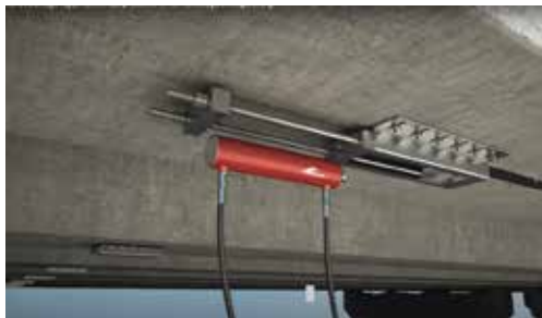
Рис.2 – Влаштування композитної зовнішньої арматури з зовнішнім підсиленням
