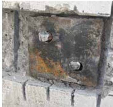
Рис.2 - Підготовлена до зварювання закладна деталь на хімічних анкерах
