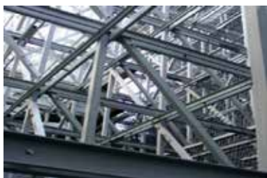
Рис.1. Загальний вигляд використання склопластикових конструкцій
