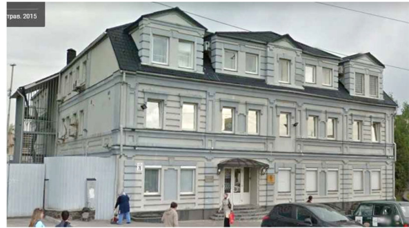
Рис.1. Будівля до реконструкції, головний фасад
