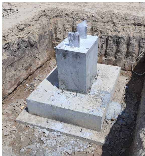
Рис.3. Фундаменти неглибокого закладання з монолітного залізобетону.
