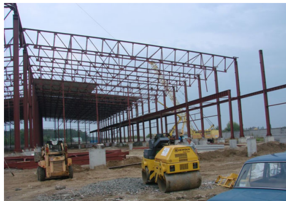
Рис.1. Загальний вигляд металевого каркасу будівлі.
